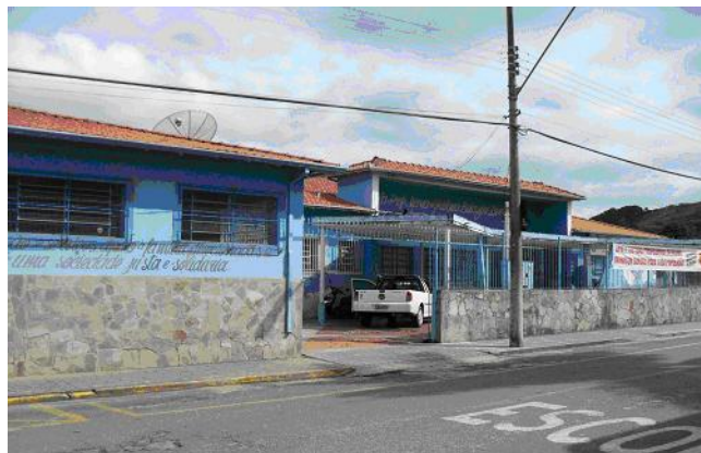
FIGURA 7 – Fachada da Apae (2003)
