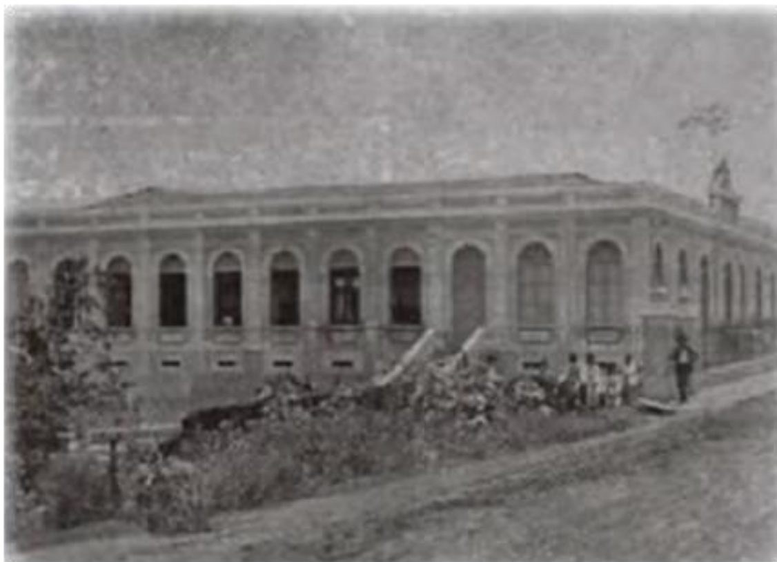
Figura 12. Grupo Escolar Dr. Jorge Tibiriçá em fase de construção, s/i data, fotógrafo desconhecido. Aproximadamente de 1906.
