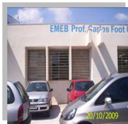
Foto 5- Fachada da escola
