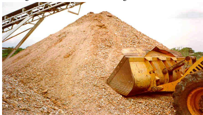
Figura 5: Resíduos de obra na argamassa do concreto
