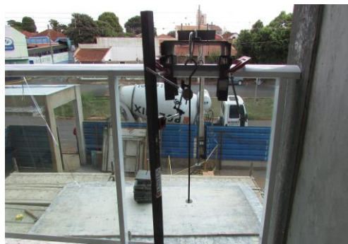
Figura 5: Posicionamento da base com chapa metálica no centro do módulo
