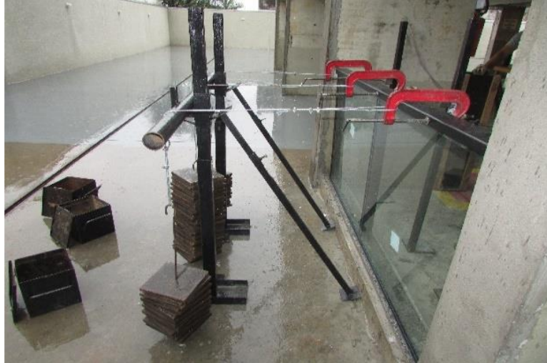
Figura 12: Aplicação da carga de segurança durante esforço estático horizontal de dentro para fora
