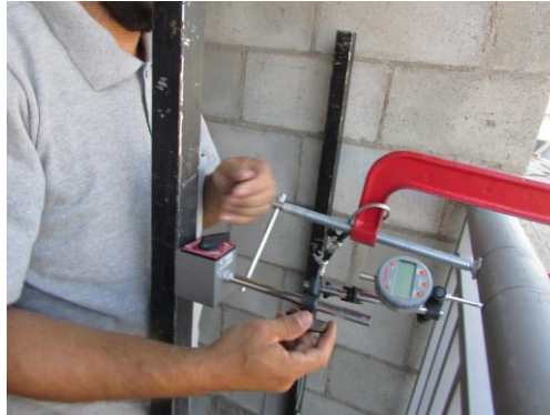
Figura 4: Posicionamento dos relógios comparadores ou deflectômetros
