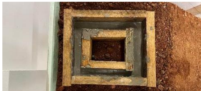
Figura 10 – Concretagem das vigas baldrames (Fonte: Próprio autor).
