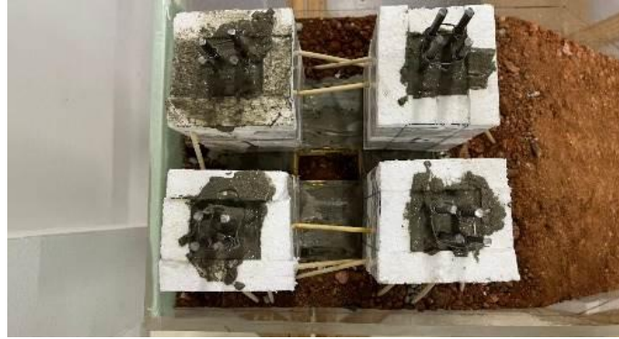
Figura 11 – Armaduras e concretagem dos pilares (Fonte: Próprio autor).
