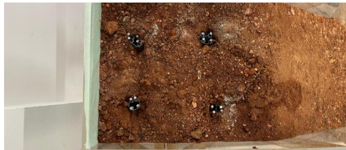
Figura 8 – Armadura da fundação (Fonte: Próprio autor).
