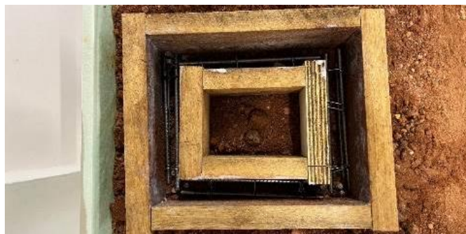
Figura 9 – Armaduras das vigas baldrames (Fonte: Próprio autor).
