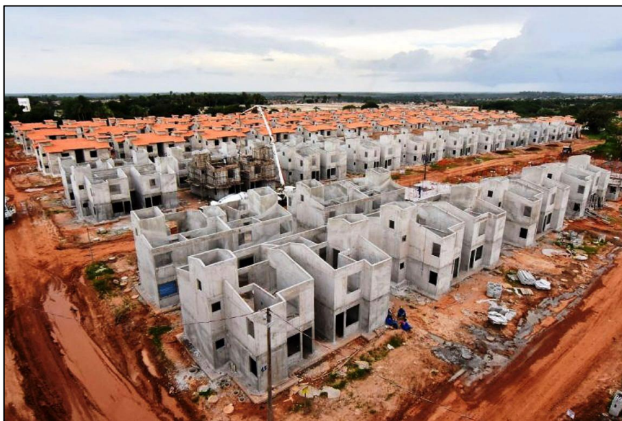
Figura 4 – Execução Pré Moldados Conjunto Habitacional
