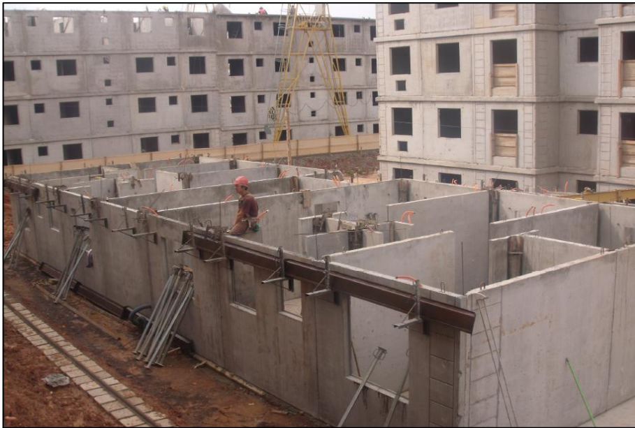
Figura 1 – Utilização Pré Moldado
