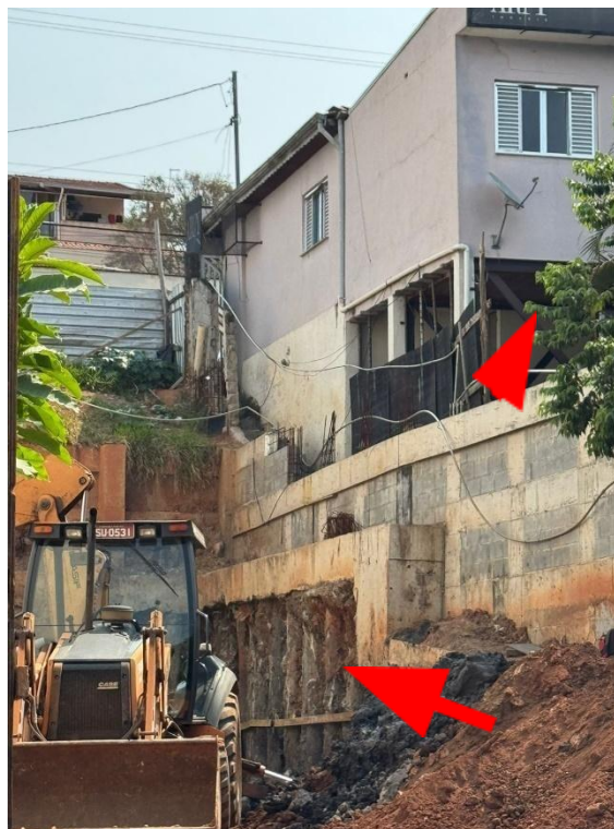
Figura 9 – Foto dos reforços executados, 2024 (Fonte: Próprio autor).
