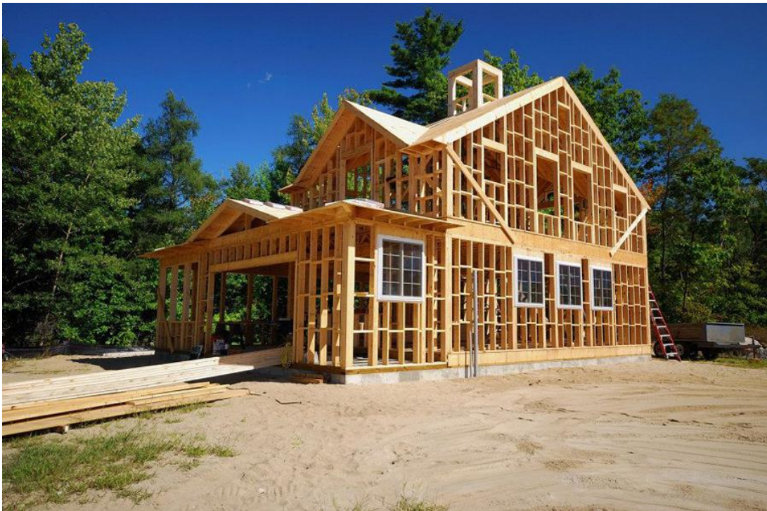
Figura 5 – construção de uma casa em wood frame Fonte: drywall.org.br
