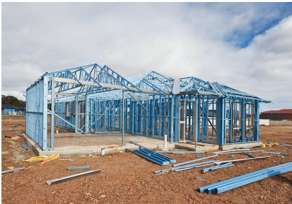
Figura 4 – construção em steel frame Fonte: maiscontroleerp
