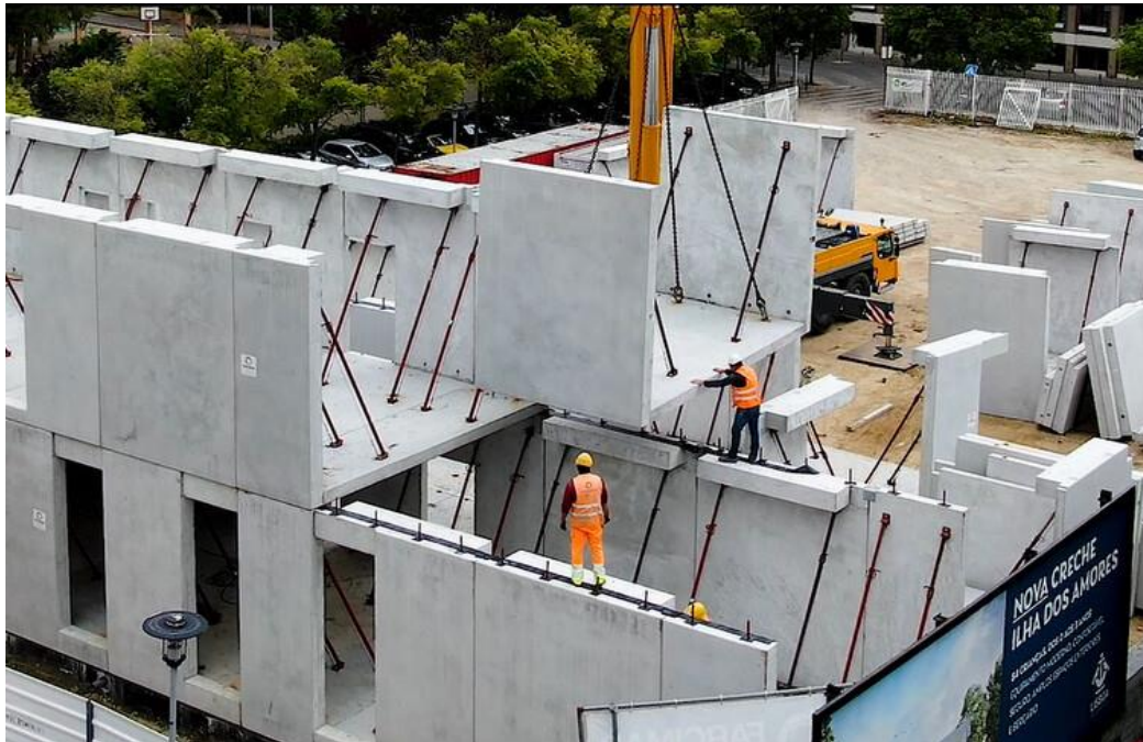
Figura 1 – exemplo de construção em pre-moldado de concreto Fonte: site da archdaily
