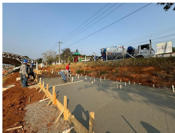
Figura 3 - Execução de radier (Fonte: Próprio autor).
