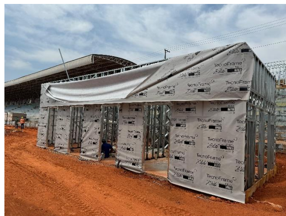
Figura 5 - Aplicação de manta hidrófoga na estrutura (Fonte: Próprio autor).
