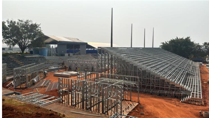
Figura 15 – Arquibancada e módulos operacionais executados em LSF (Fonte: Próprio autor).
