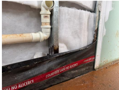
Figura 2 – Membrana impermeabilizante instalada em estrutura de LSF (Fonte: Próprio autor).
