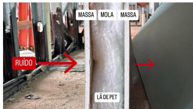
Figura 13 - Sistema massa-mola-massa (Fonte: Autor).
