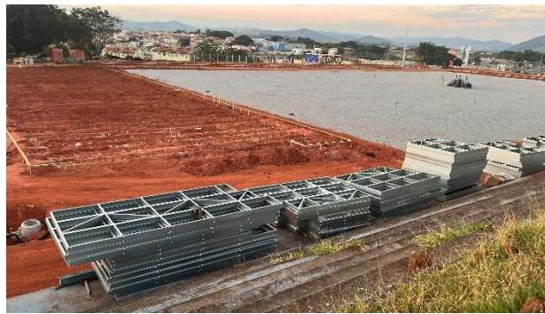
Figura 4 - Perfis dispostos em obra (Fonte: Próprio autor).
