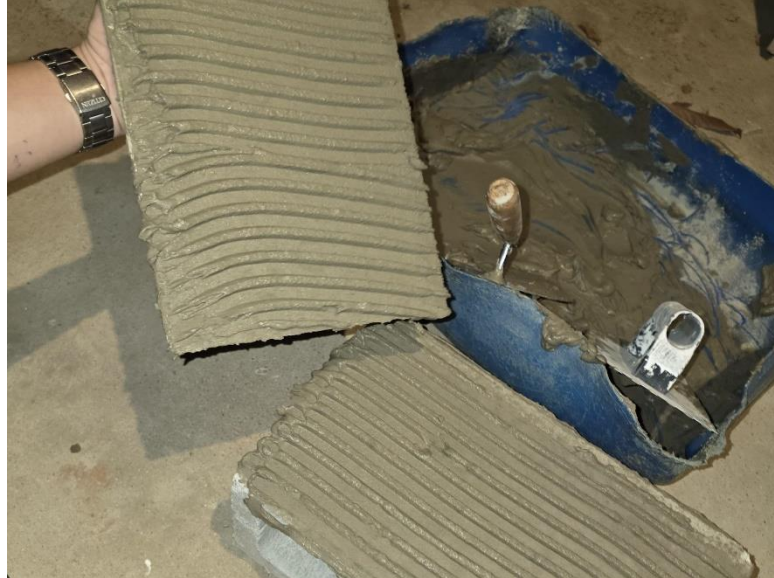
Imagem 4: Aplicação da argamassa realizando dupla colagem.
