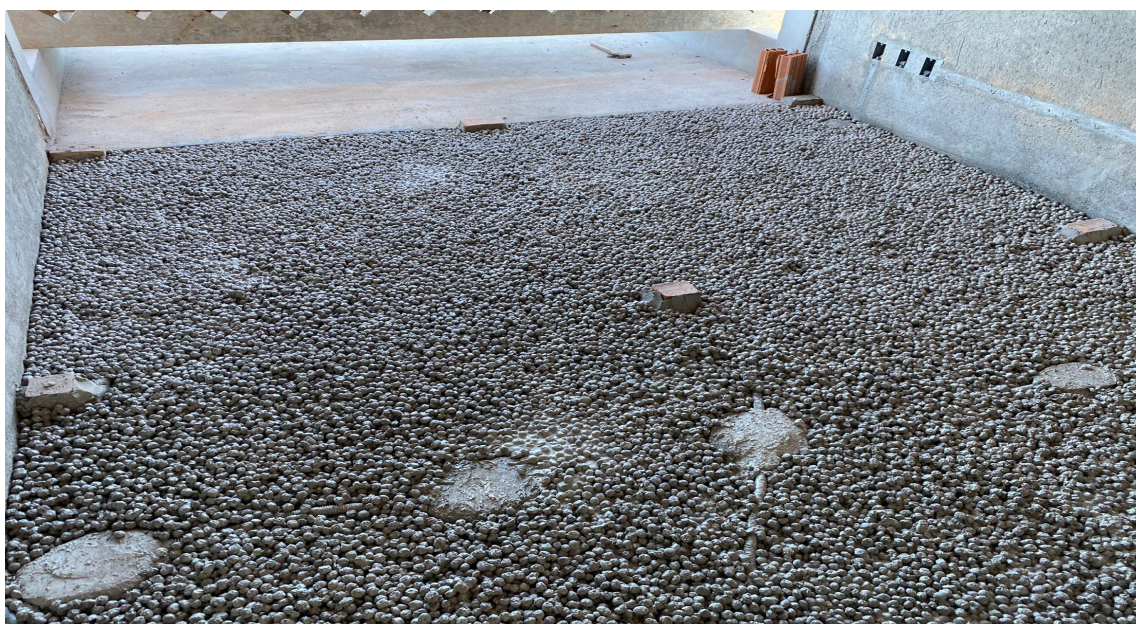
Figura 5: Nivelamento de piso com argila expandida Fonte: Autoria própria
