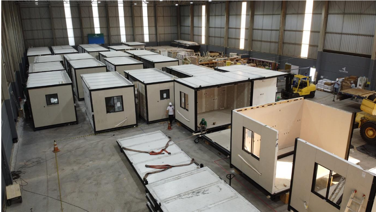
Figura 05 – Processo de fabricação casa modular em Wood Frame (Fonte: Tecverde, 2024)
