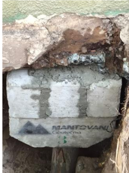
Figura 11 – Cabeçote e cunhas das estacas (Fonte: Dos autores, 2024).
