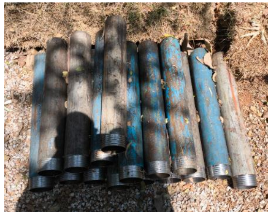
Figura 12 – Segmentos das estacas (Fonte: Dos autores, 2024).
