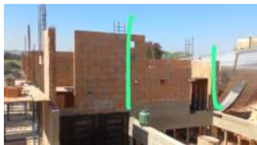
Figura 12 – Locais onde foi preciso cortar a parede FONTE: Arquivo pessoal
