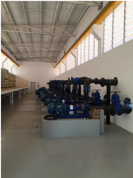
Figura 4.1 - Vista interna da subestação de distribuição
