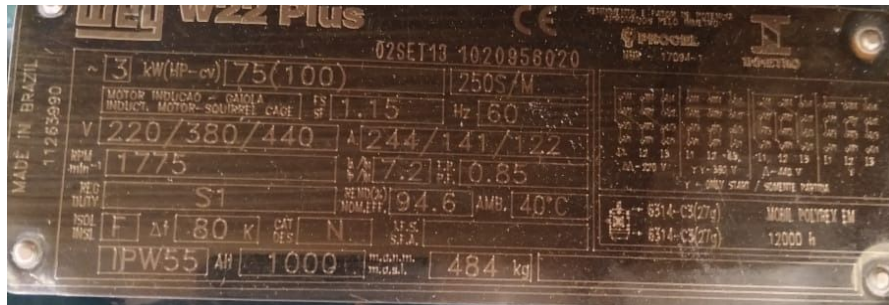
Figura 5 - Dados de Placa do Motor do Triturador de Papel
