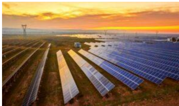
Figura 7 - Fazenda fotovoltaica (Fonte: Site Energeasysolar, 2023)
