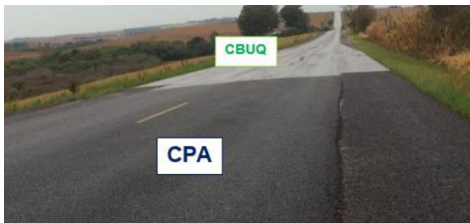
Figura 1 – Trecho em CPA seguido de trecho em CBUQ após período chuvoso (Fonte: DRESCH, 2016 adaptado por SILVEIRA, PADULA e ROCHA, 2022)
