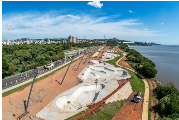
Figura 3 – Foto do parque da Orla em Porto Alegre – RS sendo construído (Fonte: Acervo Spot Skateparks, 2020).
