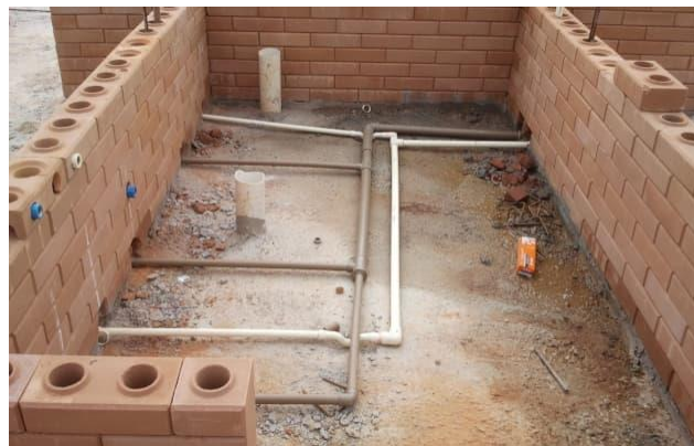
Figura 3 – Construção utilizando tijolo solo-cimento (Fonte: Escolaengenharia.com.br).
