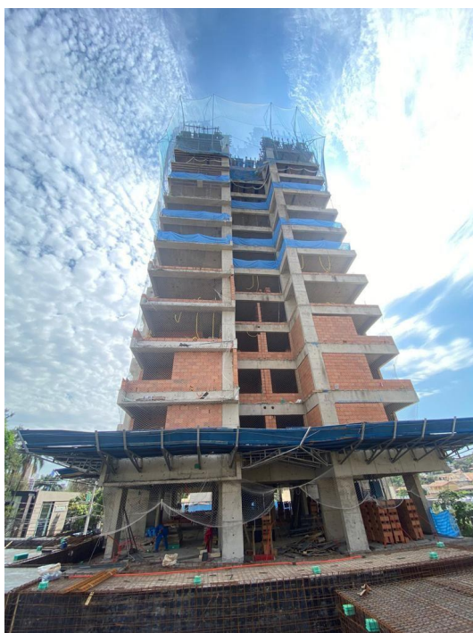
Figura 4 – Estrutura de Alvenaria de Vedação de Vista Externa. (Fonte: Elaborado pelo autor)
