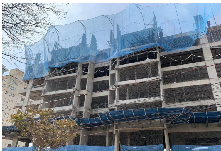
Figura 2 – Estrutura de Concreto (Fonte: Elaborado pelo autor)
