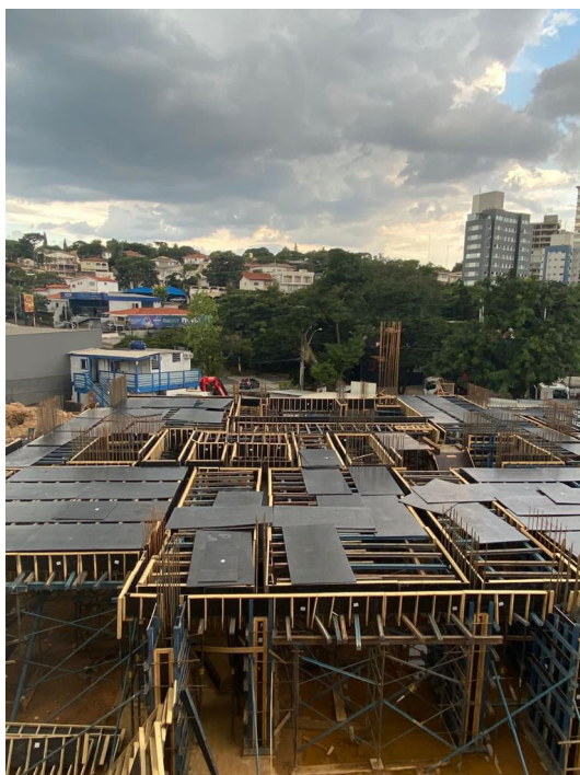
Figura 3 – Forma do 1º andar de Estrutura em Concreto (Fonte: Elaborado pelo autor)
