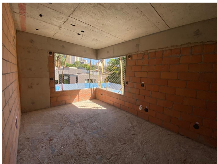
Figura 5 – Estrutura de Alvenaria de Vedação de Vista Interna. (Fonte: Elaborado pelo autor)
