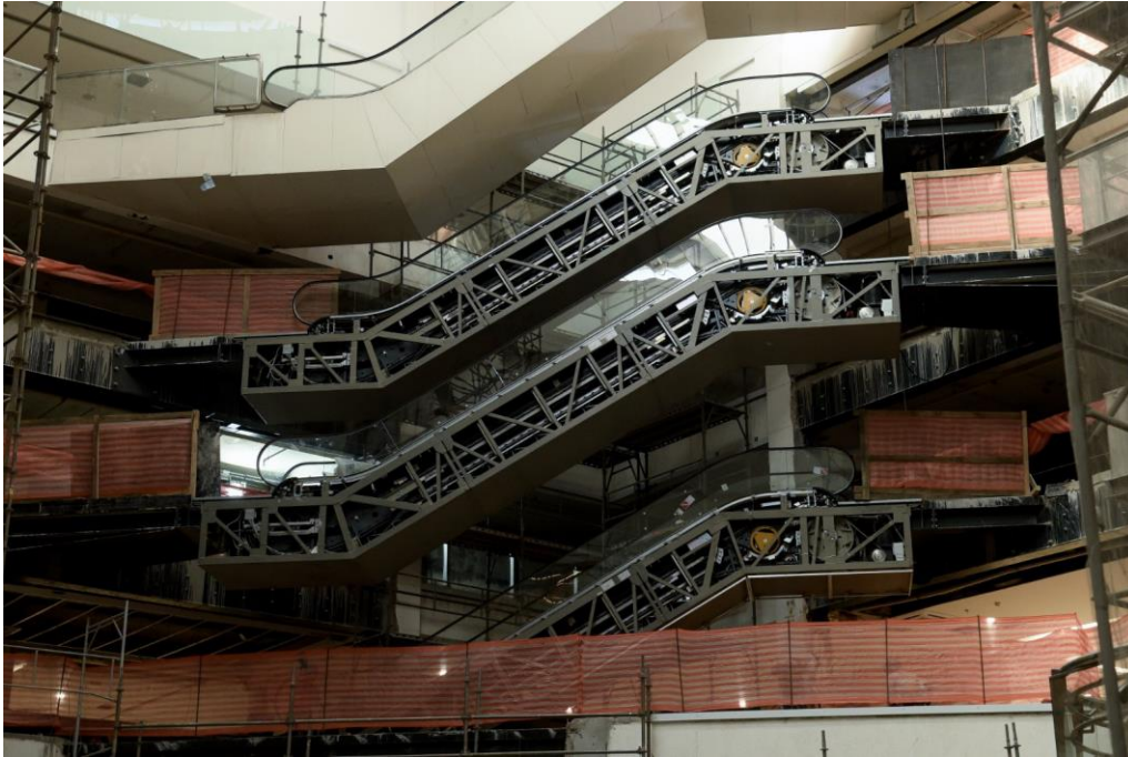
FIGURA 18 – Escadas rolantes instaladas
