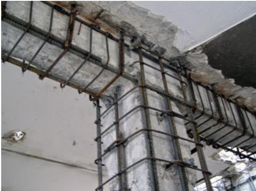
FIGURA 4 – Reforço estrutural com aumento de seção
