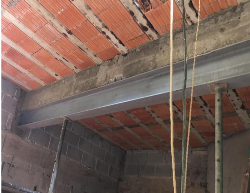
FIGURA 5 – Reforço estrutural com uma viga metálica abaixo da viga de concreto
