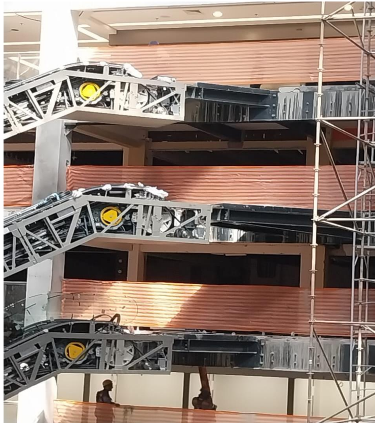
FIGURA 20 – Escadas rolantes instaladas
