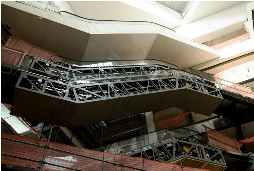
FIGURA 18 – Escadas rolantes instaladas
