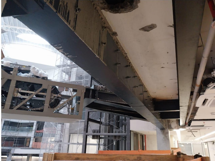
FIGURA 14 – Trabalho de reforço executado
