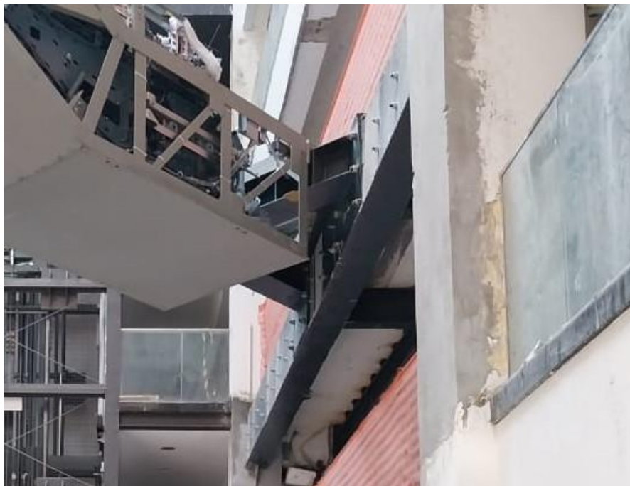
FIGURA 14 – Trabalho de reforço executado
