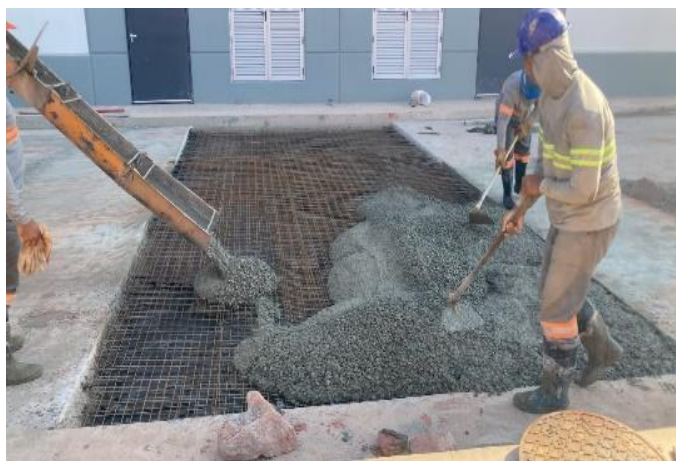
Figura 10 – Foto da execução de reparo de trinca. Cotia, São Paulo (Fonte: Próprio autor).
