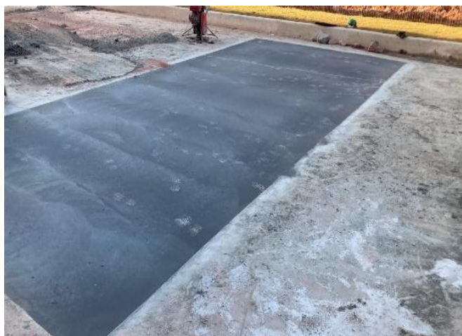
Figura 13 – Foto após a etapa de reconstrução de 33,50m 2 piso para veículos pesados com adição de fibra sintética estrutural 5kg/m 3 com espessura H=15cm. Cotia, São Paulo (Fonte: Próprio autor).
