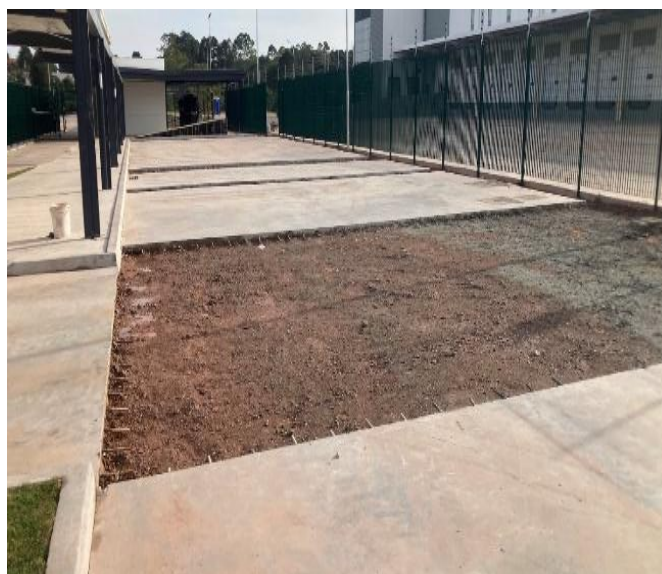
Figura 7 – Foto após a etapa de demolição. Cotia, São Paulo (Fonte: Próprio autor).
