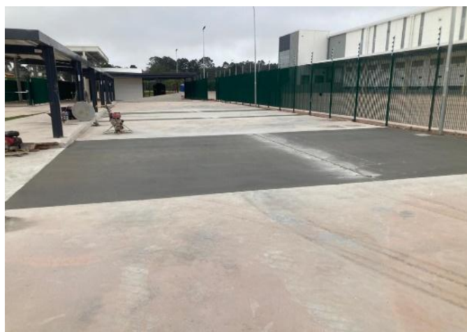
Figura 12 – Foto após a etapa de reconstrução de 103,00 m 2 piso para veículos leves com adição de fibra sintética estrutural 4kg/m 3 com espessura H=10cm. Cotia, São Paulo (Fonte: Próprio autor).
