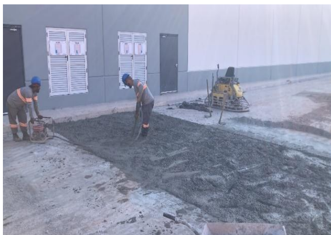
Figura 11 – Foto de processo de vibração por imersão durante a execução de reparo de trinca. Cotia, São Paulo (Fonte: Próprio autor).
