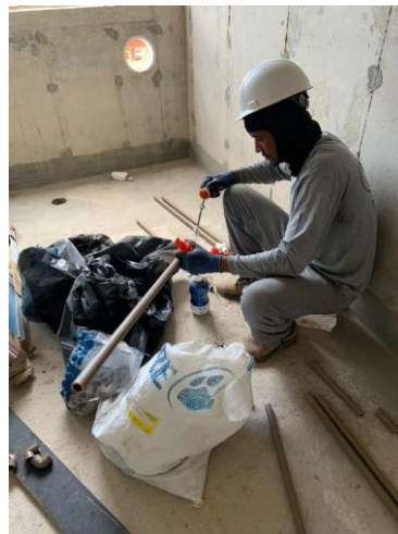
Figura 06 e 07 – Corte e montagem de instalações hidráulicas sendo realizadas in loco (Fonte: Autores, 2023).
