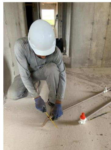
Figura 06 e 07 – Corte e montagem de instalações hidráulicas sendo realizadas in loco (Fonte: Autores, 2023).
