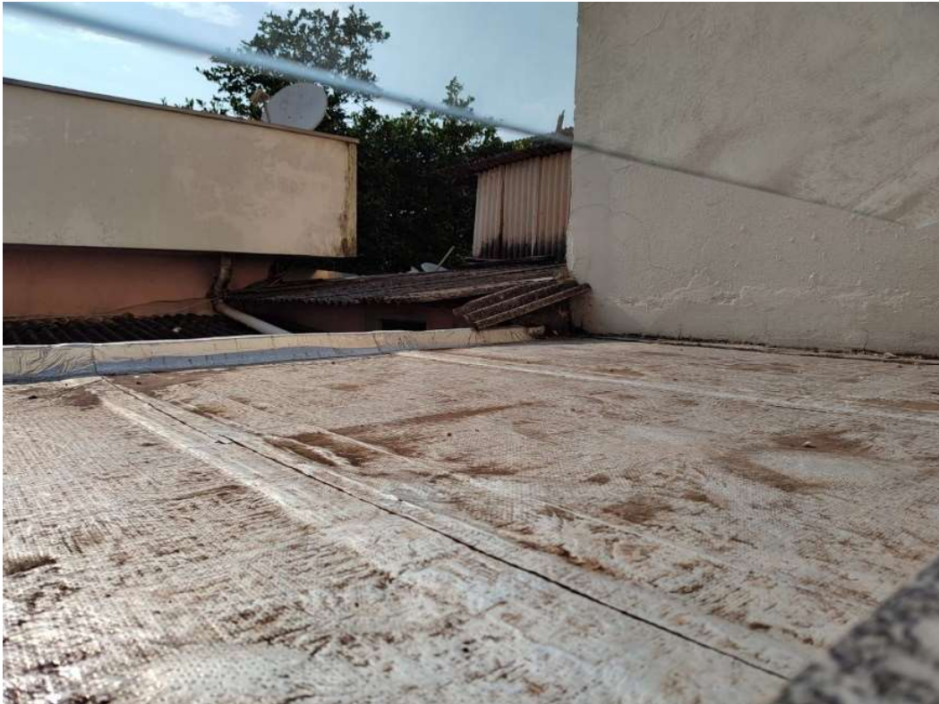
Figura 9 – Vista superior à laje com manta asfáltica existente.
