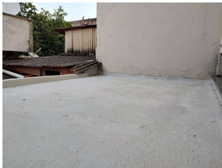
Figura 12 – Terceira demão de aplicação do produto Manta Líquida Premium.
