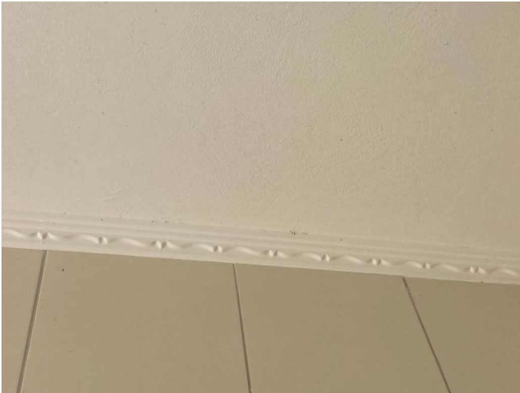
Figura 13 – Fase final do processo de impermeabilização do local número 1.
