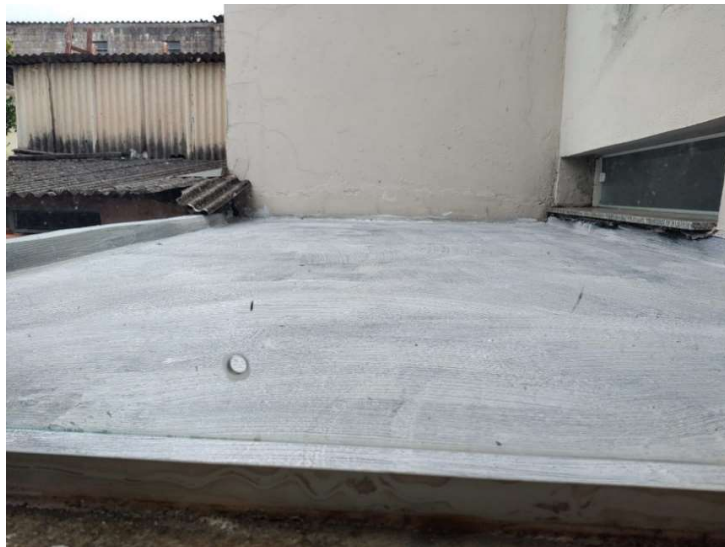
Figura 11 – Aplicação produto Manta Líquida Premium.
