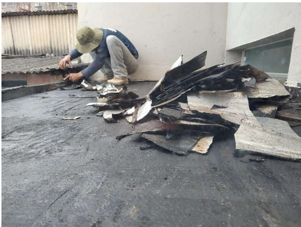
Figura 10 – Remoção da manta asfáltica, com auxílio de espátula.
