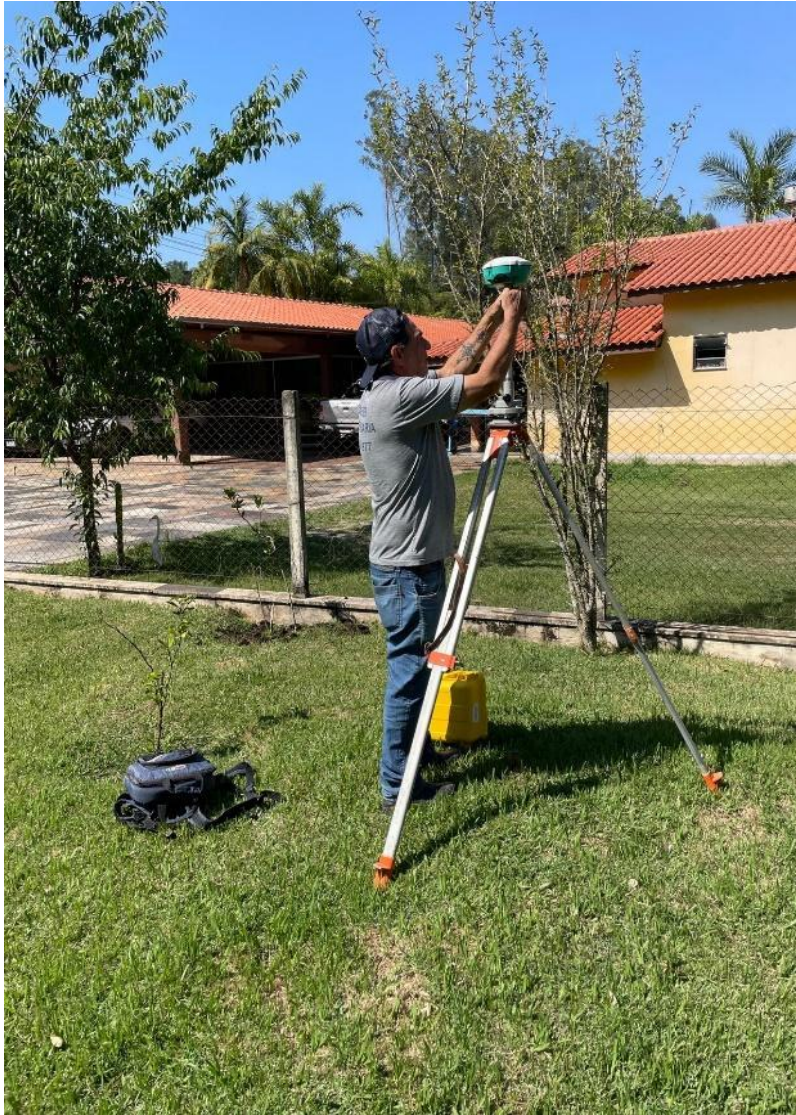
Figura 6: Desmontagem do equipamento R90i GNSS
