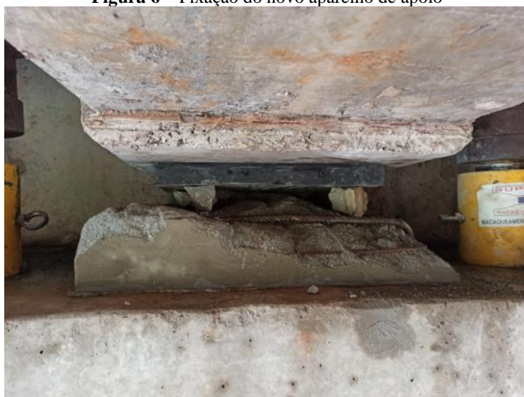
Figura 6 – Fixação do novo aparelho de apoio
