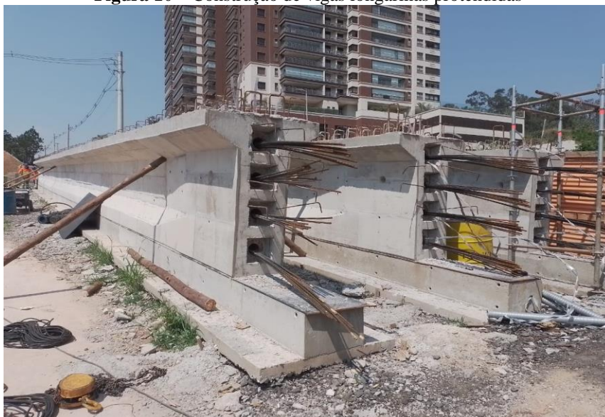
Figura 10 – Construção de vigas longarinas protendidas
