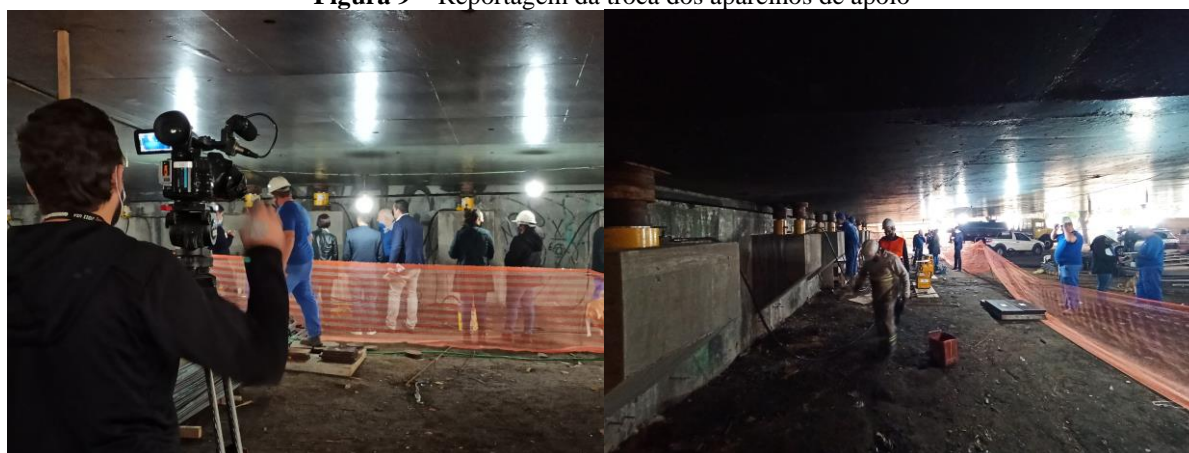
Figura 9 – Reportagem da troca dos aparelhos de apoio
