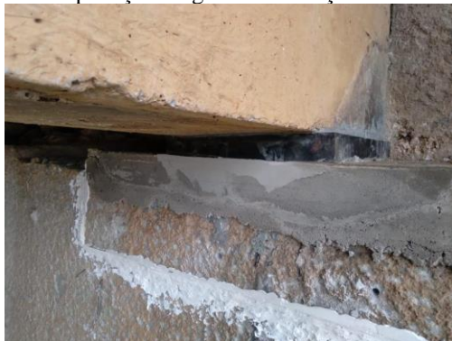
Figura 7 – Aplicação do graute e remoção do escoramento
