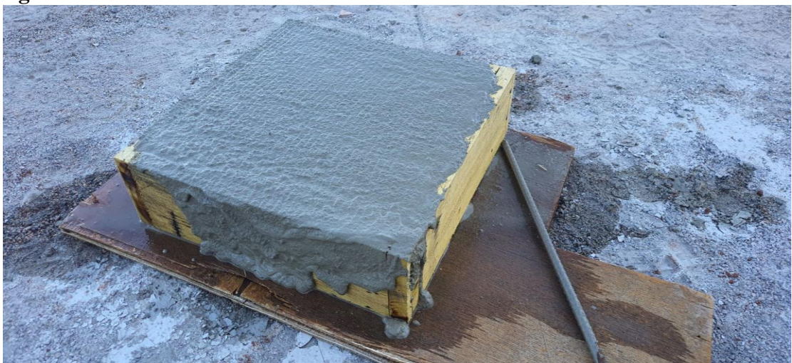
Figura 3 - Placa de Concreto.
