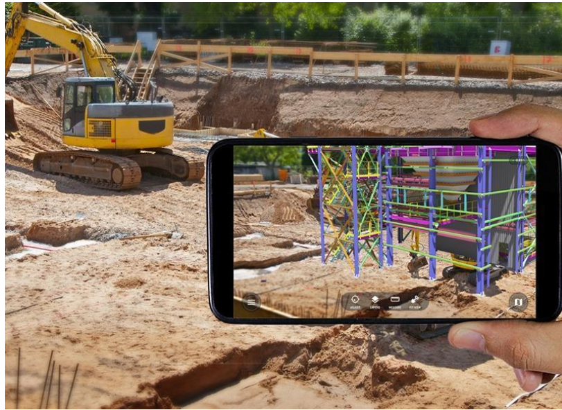
Figura 9: Sobreposição da estrutura compatibilizada em tempo real na obra
