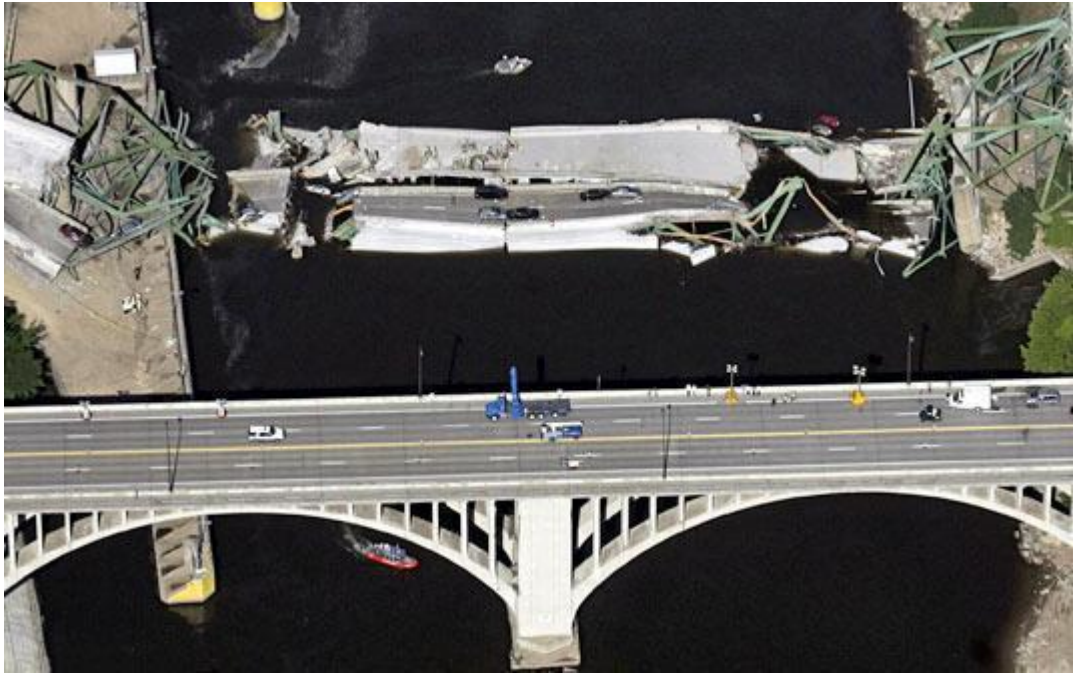
Figura 3: Imagem aérea dos escombros da ponte
