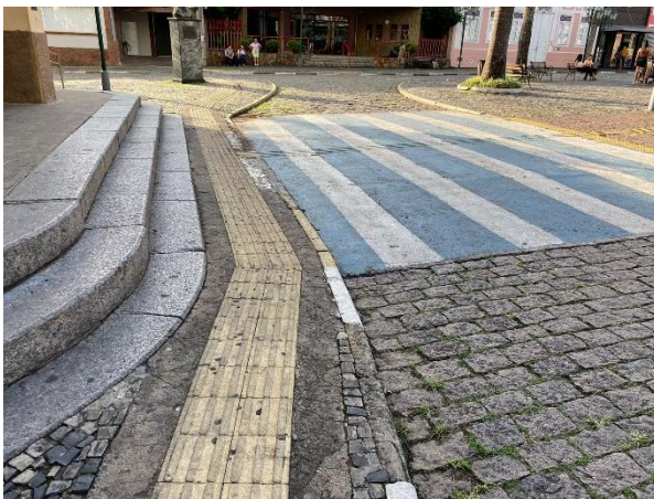
Figura 5: Calçada com largura inferior ao mínimo permitido.
