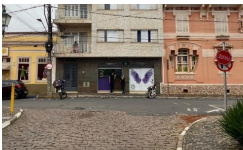
Figura 14: Falta de manutenção das placas.
