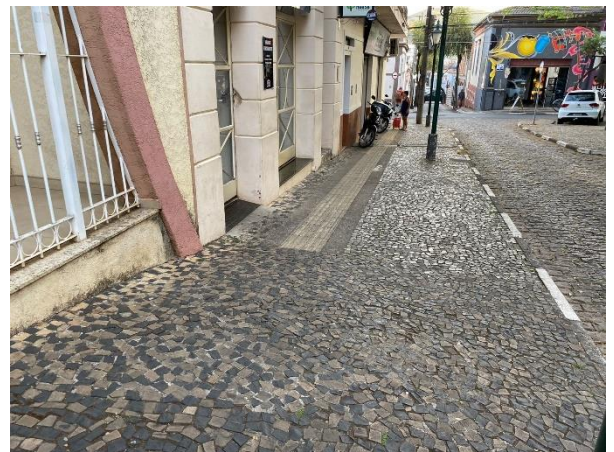
Figura 6: Calçada com largura de acordo com a NBR 9050:2015.
