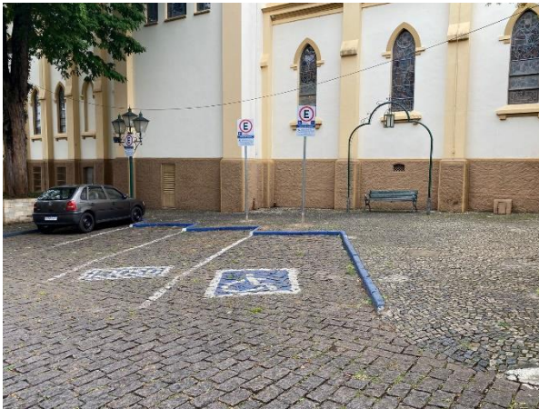
Figura 11: Vagas de idoso e deficiente, sem espaço adicional ou próxima a faixa de travessia de pedestres.
