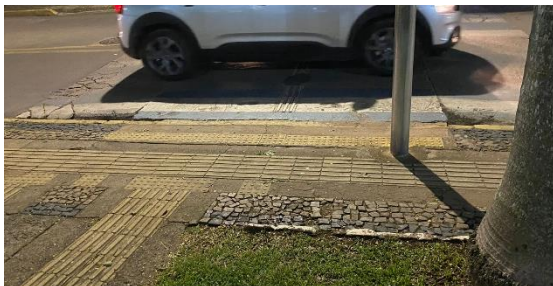
Figura 18: Falta de ligação e poste invadindo o piso tátil.
