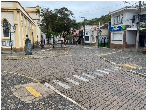
Figura 7: Rebaixamentos que não atendem a largura e inclinação.
