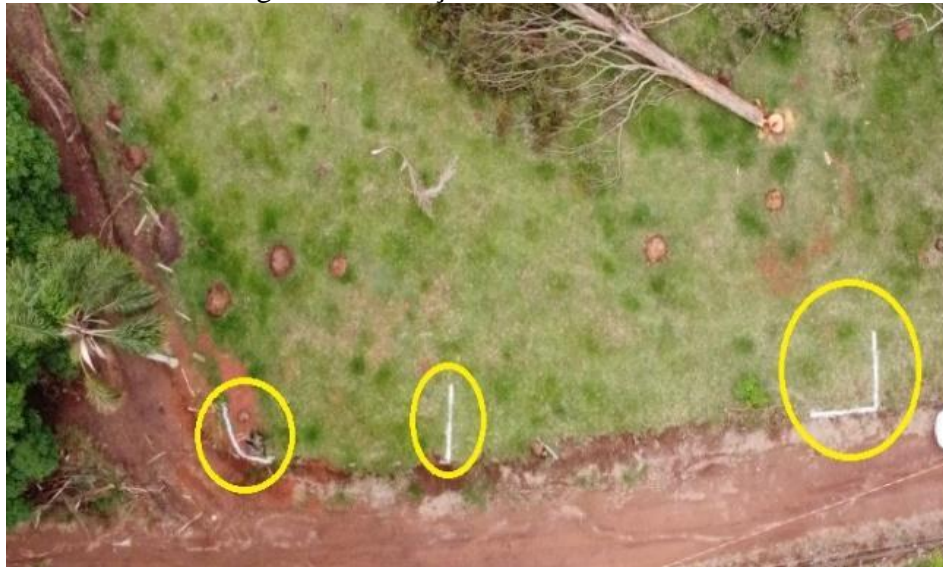
Figura 6: marcação em cal vista com o VANT
