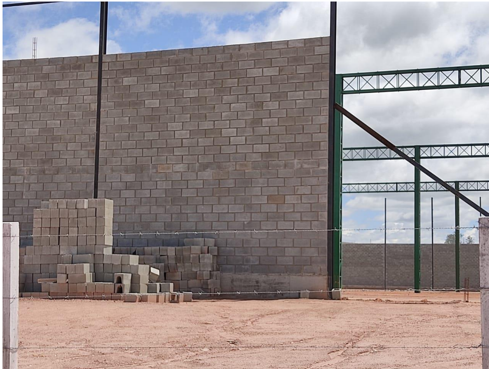
Figura 1 – Construção de galpão industrial.
