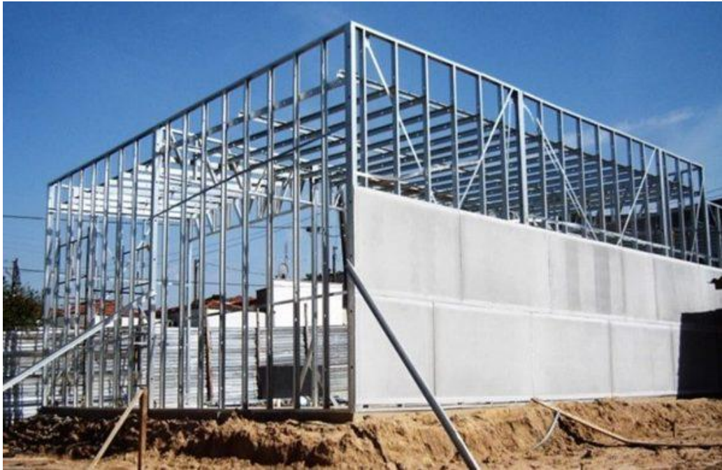
Figura 3 – Montagem de Galpão em Light Steel Frame
