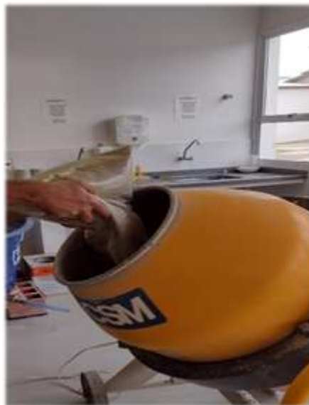
Figura 9: Betoneira sendo preenchida com material, para execução da etapa de mistura- (Fonte: Próprio autor).
