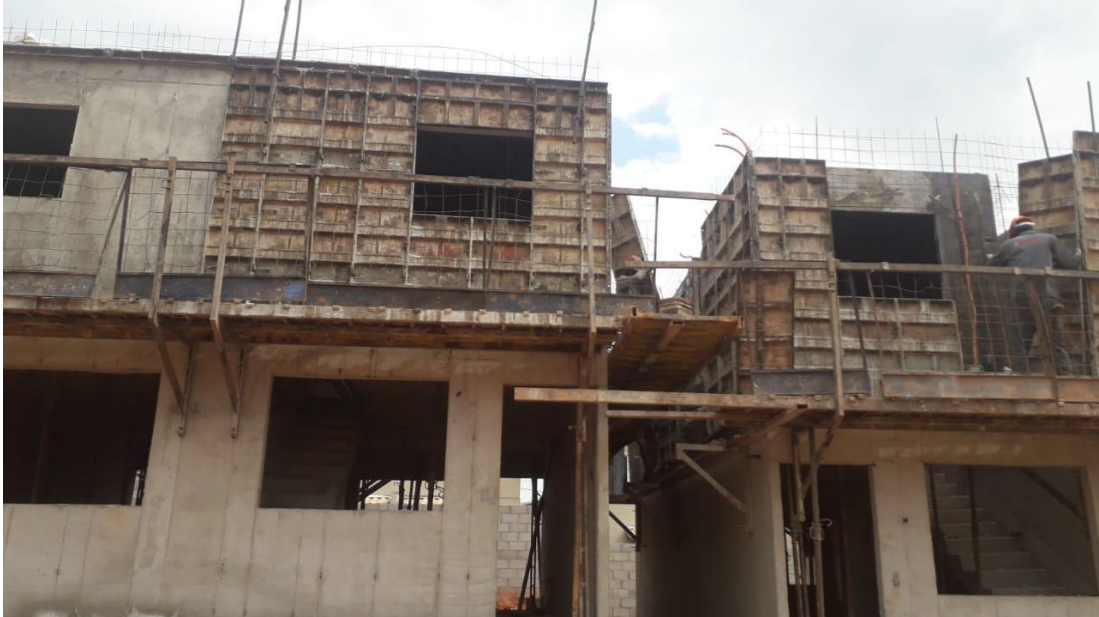
Figura 24 – Desforma de uma fôrma de concreto
