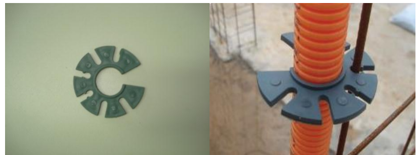
Figura 8 - Espaçador de Eletroduto Fonte: O Autor
