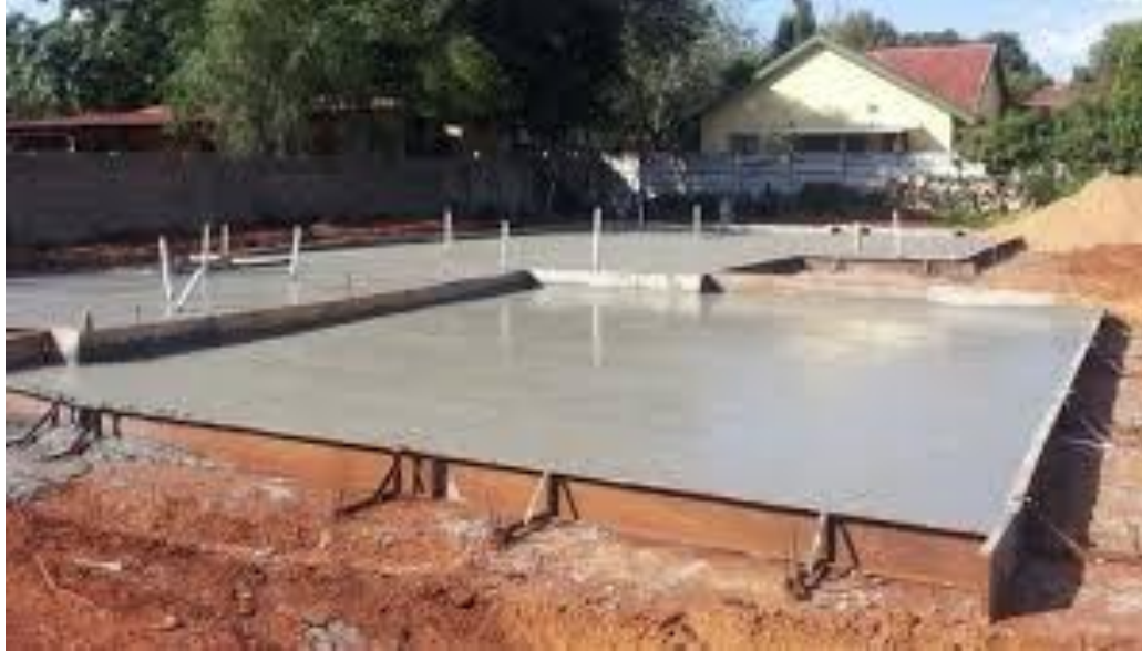
Figura 2 - Radier Fonte: Portal Construção
