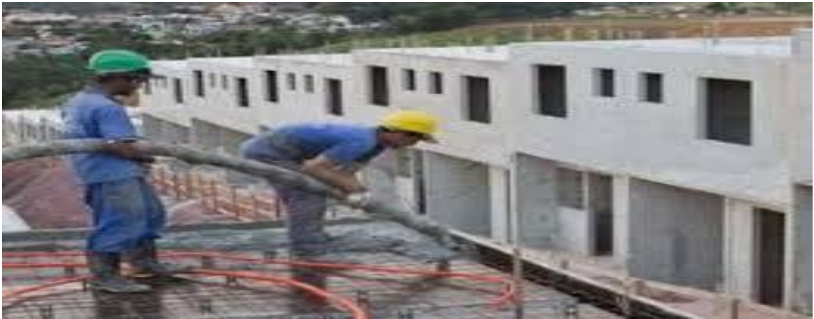
Figura 17 - Início de Concretagem Fonte: Repositorio UFMG
