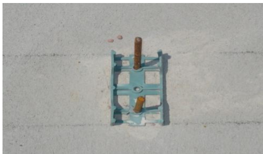
Figura 9 - Espaçador Posicionador Fonte: O Autor
