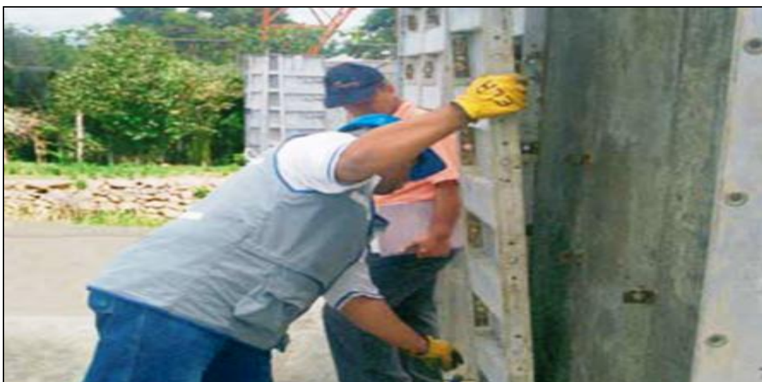
Figura 22 - Retirada dos painéis Fonte: O Autor
