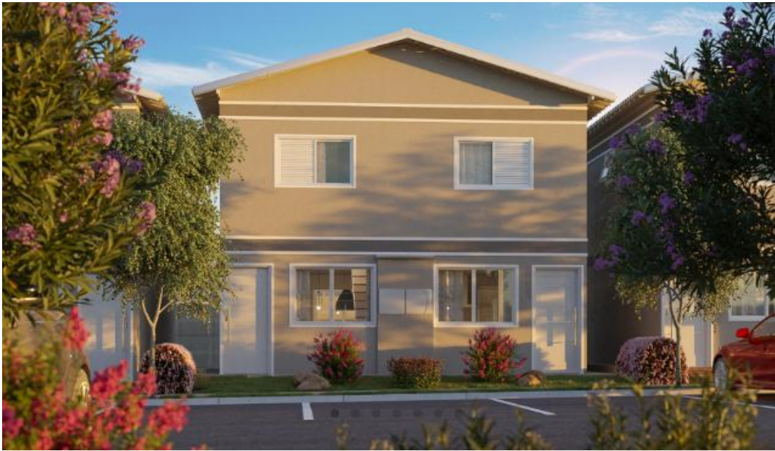
Figura 23 - Residencial Parque das Cerejeiras Fonte: RPS Engenharia
