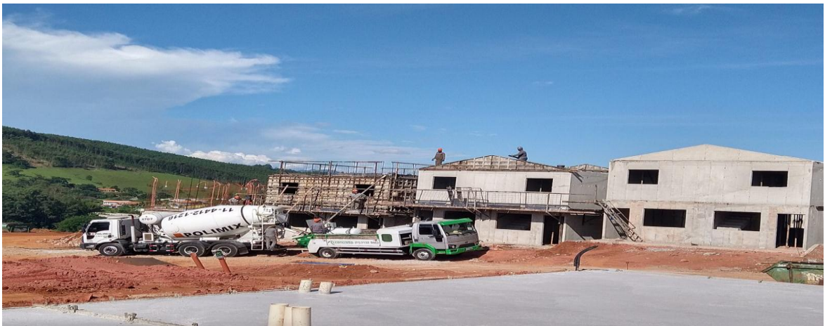
Figura 18 - Concretagem de uma fôrma Fonte: O Autor
