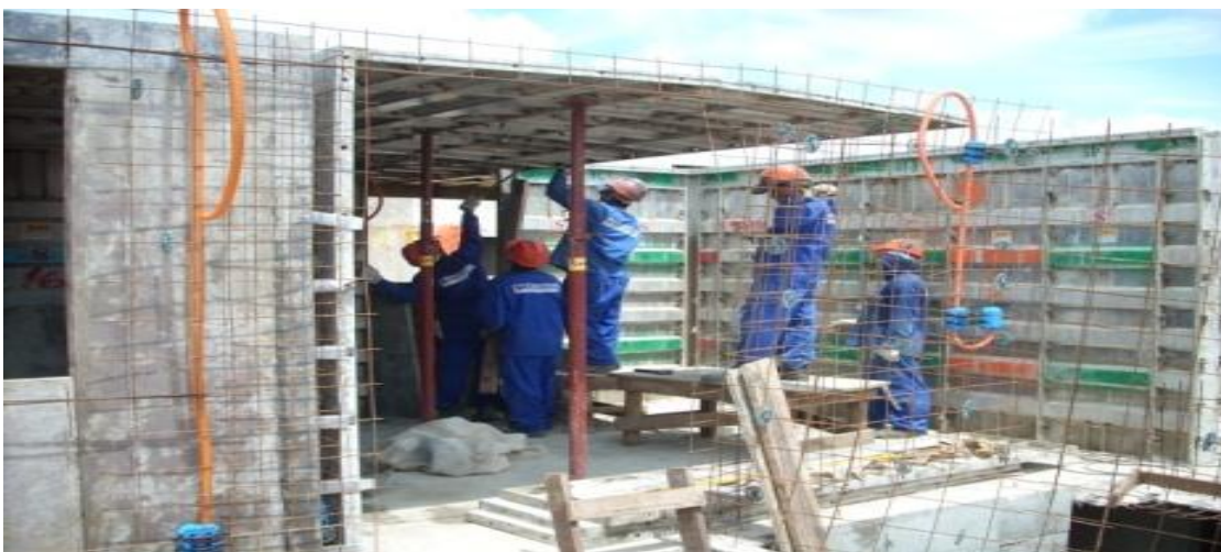
Figura 15 - Montagem da Fôrma
