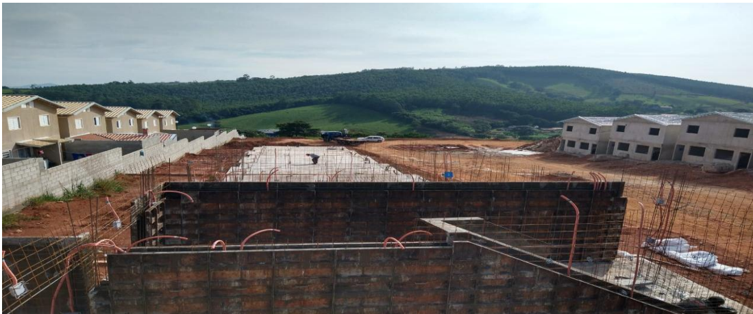
Figura 21 - Montagem da Fôrma Fonte: O Autor
