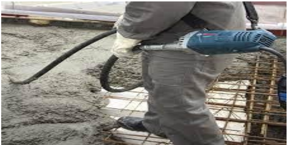
Figura 19 - Vibração de um concreto Fonte: Cefeq
