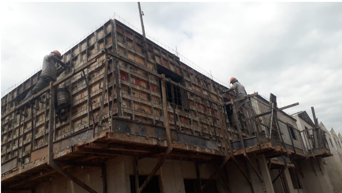
Figura 25 – Montagem de uma fôrma de concreto
