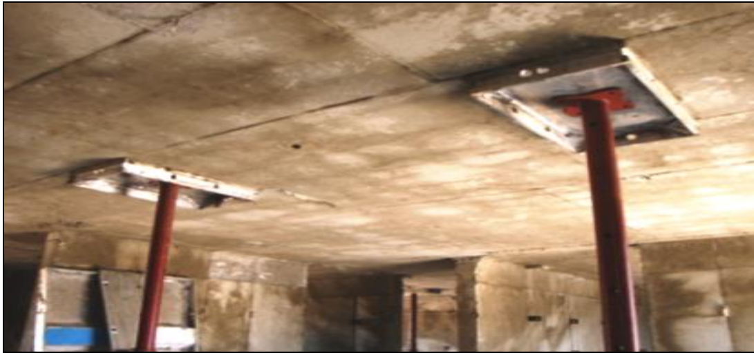
Figura 20 - Escoras permanentes Fonte: O Autor
