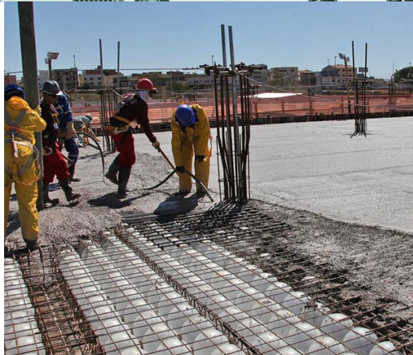
Figura 5 – Concretagem – (Fonte: BubbleDeck Brasil, 2020)
