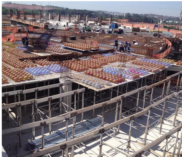
Figura 1 – Escoramento – (Fonte: BubbleDeck Brasil, 2020)
