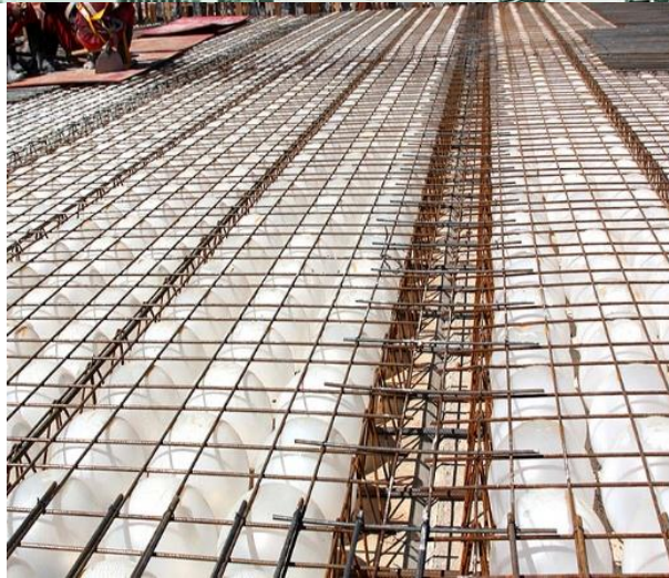
Figura 3 - Reforço armadura – (Fonte: BubbleDeck Brasil, 2020)
