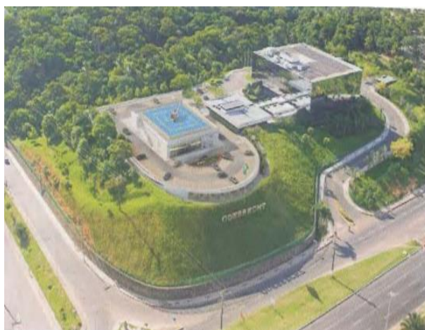
Figura 9 – Ampliação do Edifício sede da Odebrecht em Salvador - (Fonte: Odebrecht Infraestrutura, 2018)
