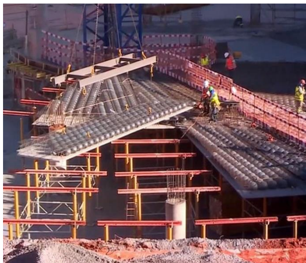
Figura 2 - Posicionamento dos painéis – (Fonte: BubbleDeck Brasil, 2020)
