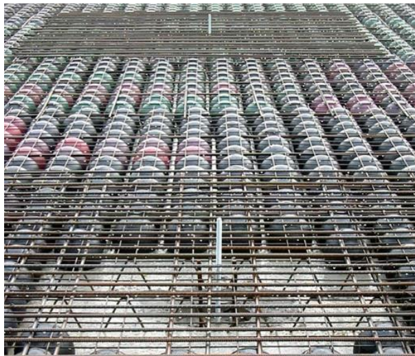
Figura 4 - Armadura adicional – (Fonte: BubbleDeck Brasil, 2020)
