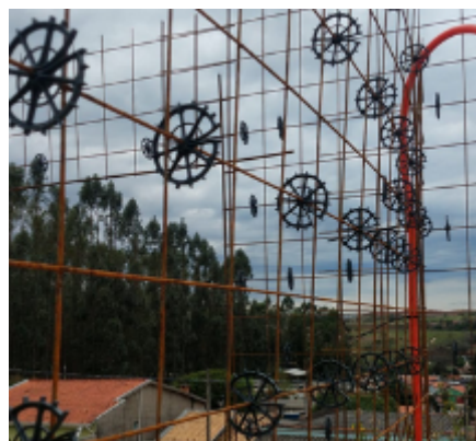
Figura 5: Posicionamento das armaduras com espaçadores
