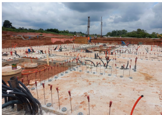
Figura 4: Fundação radier com espaçadores.
