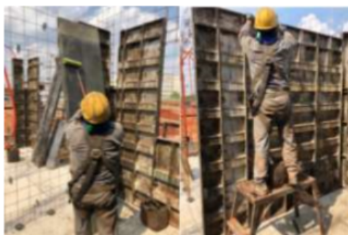
Figura 9: Montagem de fôrmas metálicas
