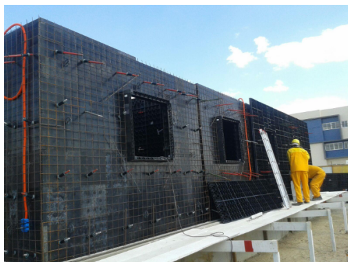
Figura 10: Uso do polímero de engenharia na construção civil.
