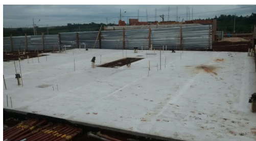
Figura 11: Radier pronto e início de marcação.
