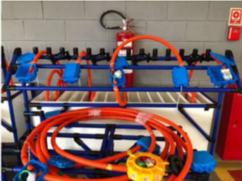
Figura 6: Instalações elétricas segundo a NBR 5410.
