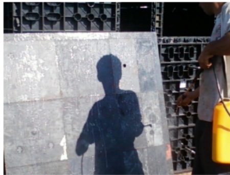
Figura 13: Aplicação do desmoldante na fôrma
