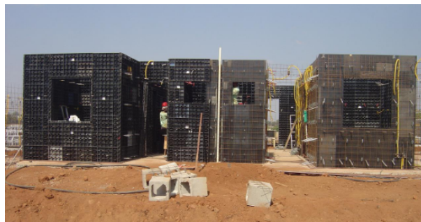
Figura 14: Colocação das ancoragens e distanciadores
