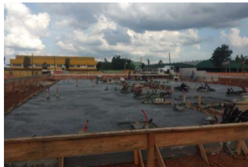
Figura 3: Terreno após concretagem do radier.
