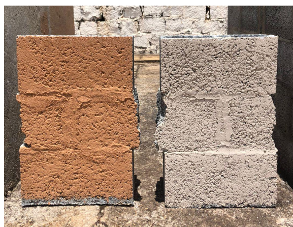
Figura 12 - Tintas ecológica e convencional aplicadas em paredes não rebocadas - (Fonte: Próprios autores).
