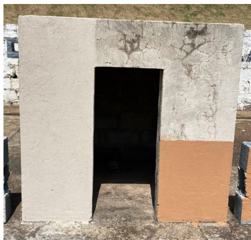
Figura 11 - Tintas ecológica e convencional aplicadas em parede rebocada já existente - (Fonte: Próprios autores).
