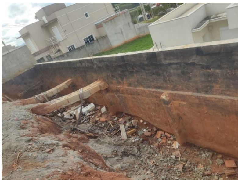
Figura 10 – Muro sem o aterro (Fonte: Próprio Autor)
