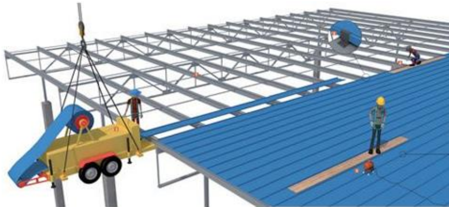
Figura 10 – Animação da instalação das telhas zipadas. Itatiba, São Paulo (Fonte: Soler).
