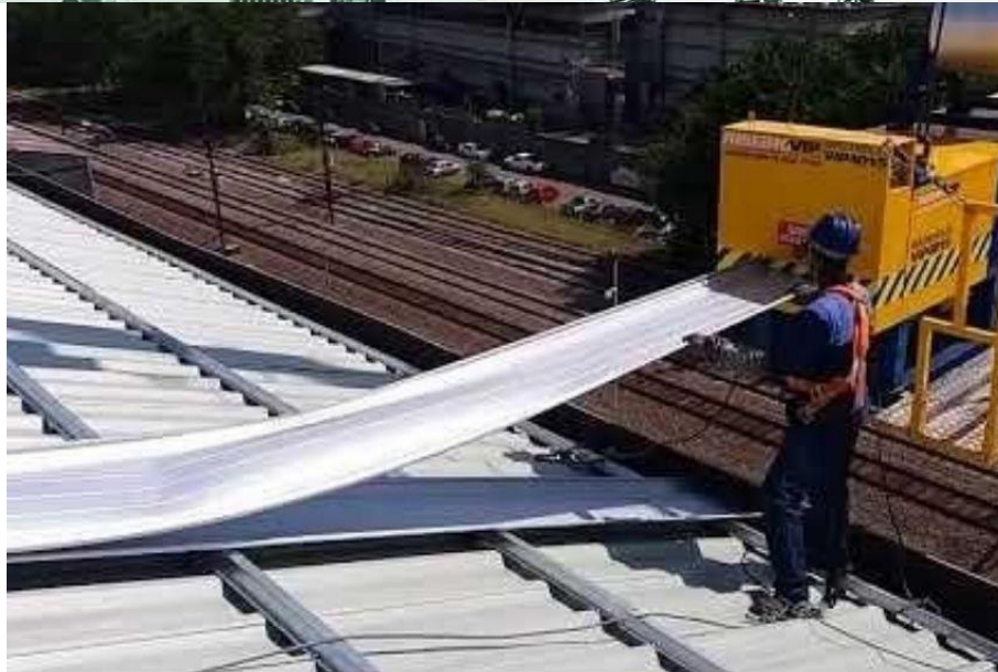
Figura 11 – Perfilamento das telhas zipadas. Itatiba, São Paulo (Fonte: Canal Solar).
