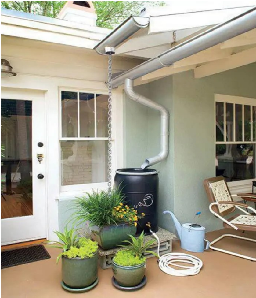
Figura 2 – Foto de uma minicisterna para reuso da captação de água da chuva através de calhas. (Fonte: https://imagens-revista-pro.vivadecora.com.br/uploads/2021/05/A-minicisterna-tamb%C3%A9m-supre-a-necessidade-daquelles-que-moram-em-im%C3%B3veis-pequenos.-Fonte-Catraca-Livre.jpg ).
