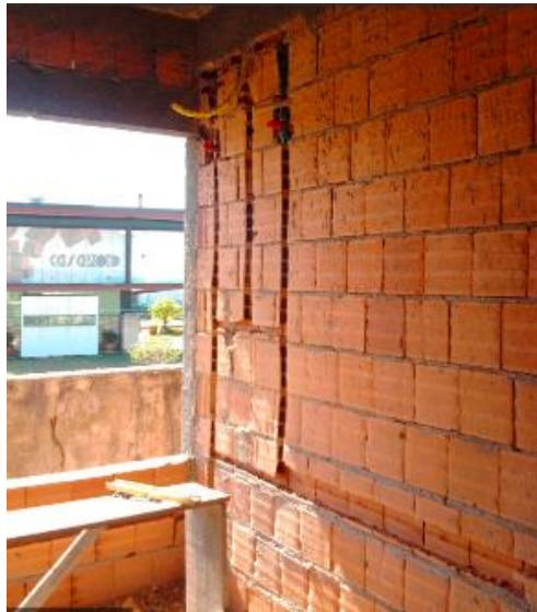
Figura 7 – Rasgos na alvenaria para instalações elétricas e hidráulicas (Fonte: próprio autor)
