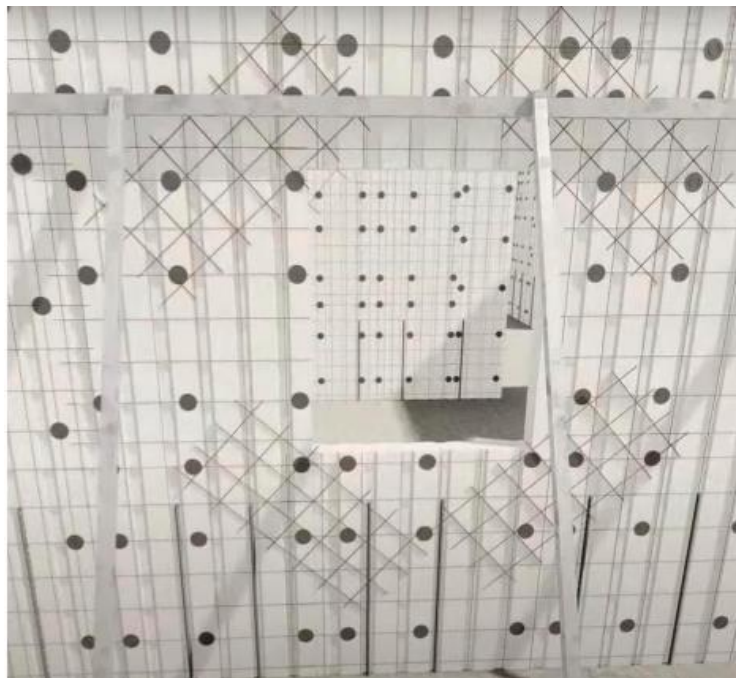
Figura 15 – Alinhamento dos painéis (Fonte: Isoalfa)
