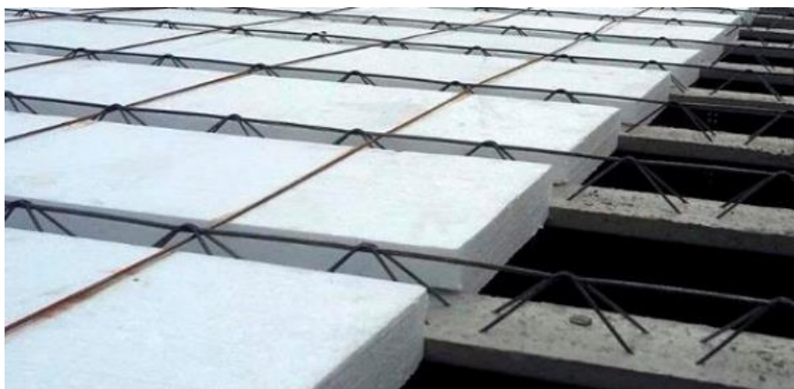
Figura 21 – Laje pré-fabricada treliçada com lajotas de EPS (Fonte: ISORECORT)
