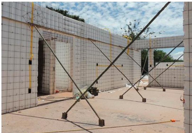
Figura 14 – Alinhamento dos painéis (Fonte: Paredes Betel)
