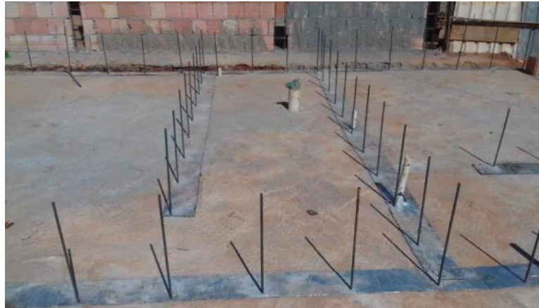
Figura 13 – Fixação dos arranques (Fonte: SALGADO, 2019)
