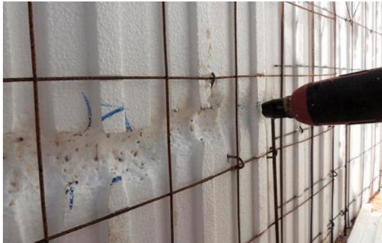
Figura 17 – Abertura no painel para instalações complementares (Fonte: Paredes Betel)
