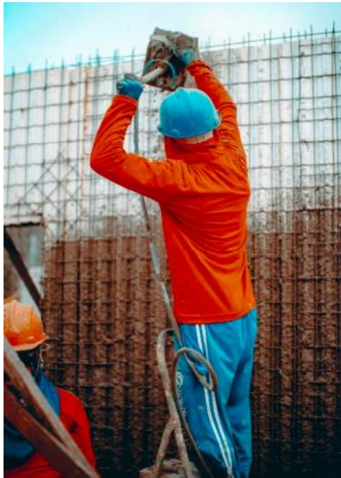
Figura 19 – Aplicação de revestimento (Fonte: Paredes Betel)
