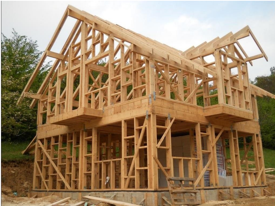
Figura 5: Esqueleto em madeira de uma construção residencial
