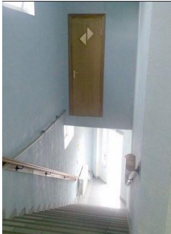
Figura 9: Porta sem acesso a uma escada
