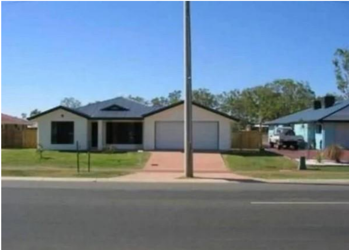
Figura 11: Poste de luz em frente a garagem
