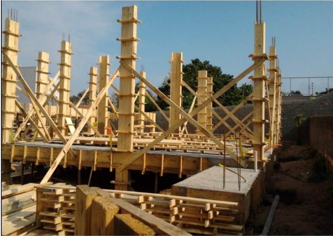
Figura 3: Fase das fôrmas dos pilares para concretagem
