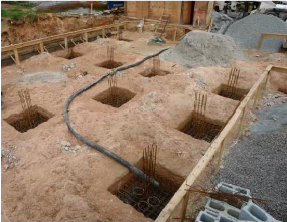
Figura 1: Fase das fundações
