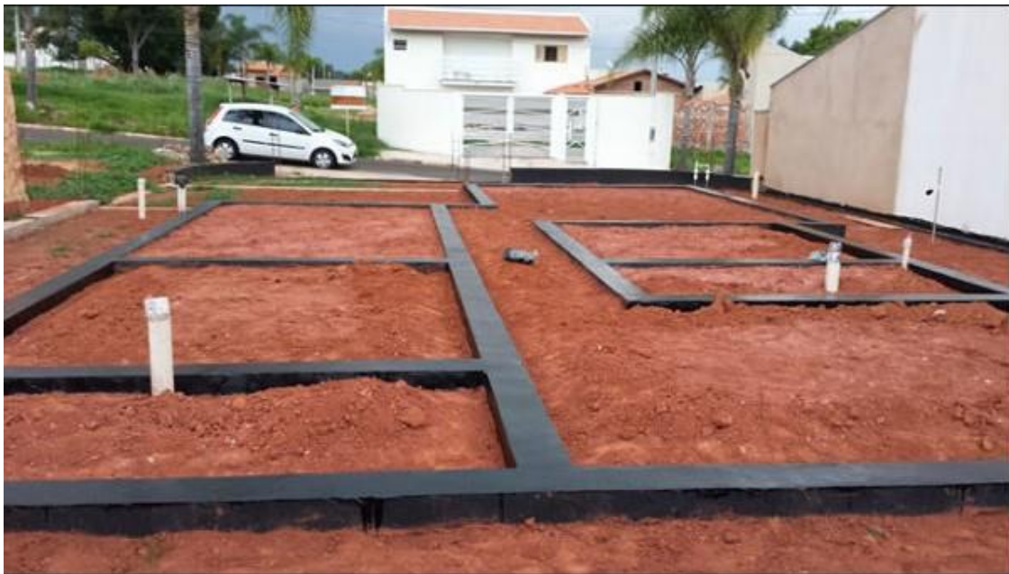
Figura 2: Fase das vigas baldrame impermeabilizados
