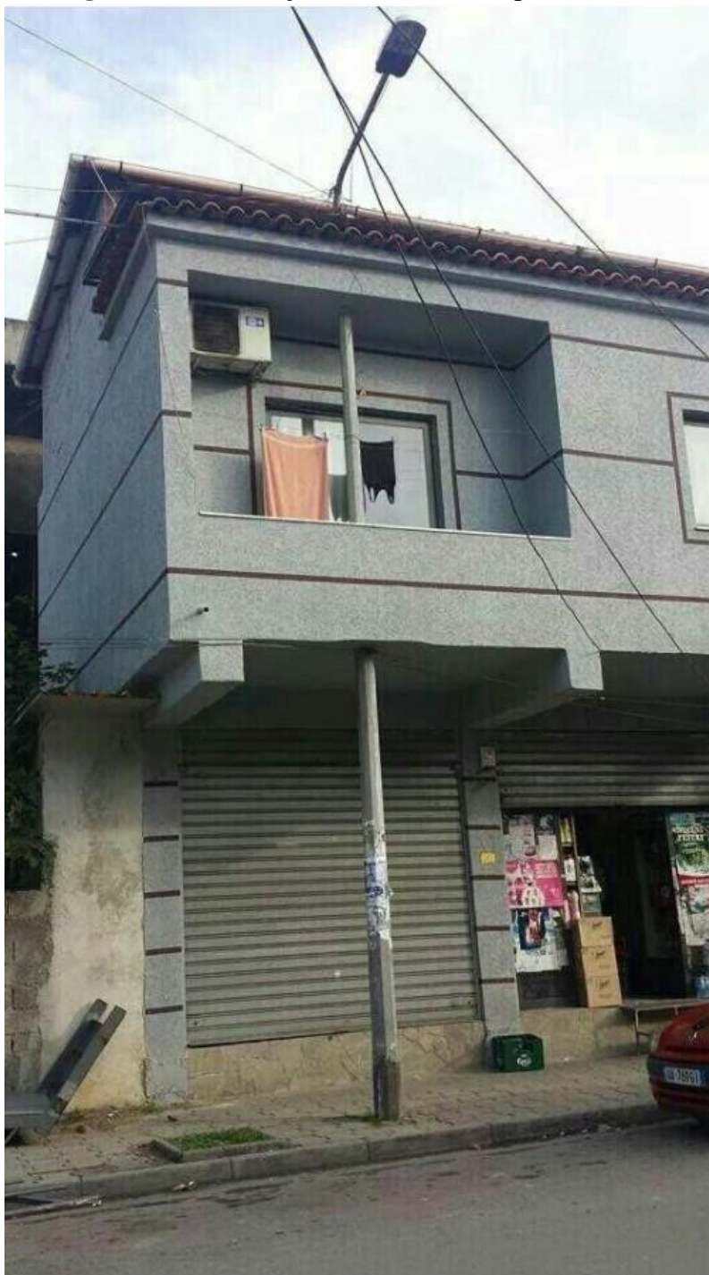
Figura 10: Construção em volta de um poste de Luz
