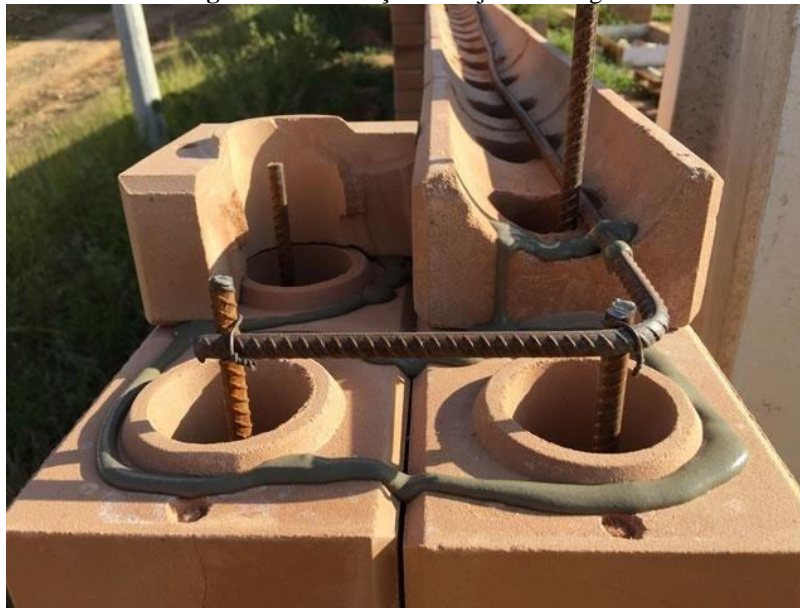
Figura 1: Construção de Tijolo Ecológico
