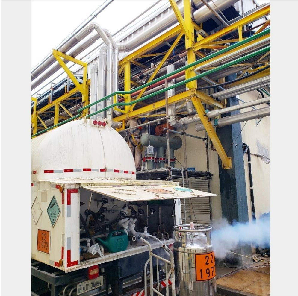
Figura 2: Caminhão tanque de nitrogênio ligado à camisa
