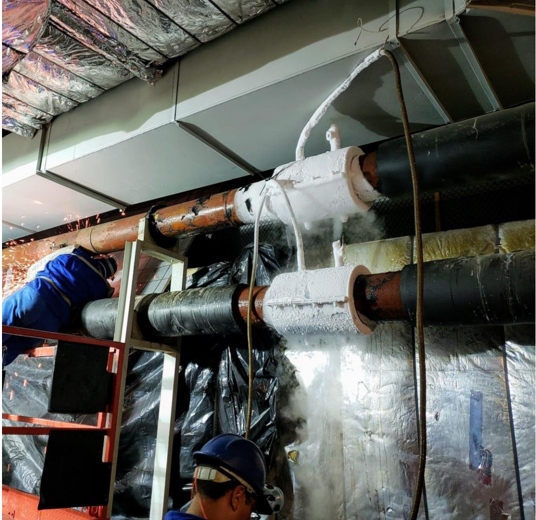
Figura 3: Congelamento hidráulico em tubulação
