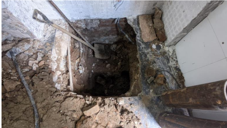
Figura 20 - Abertura da Vala.
