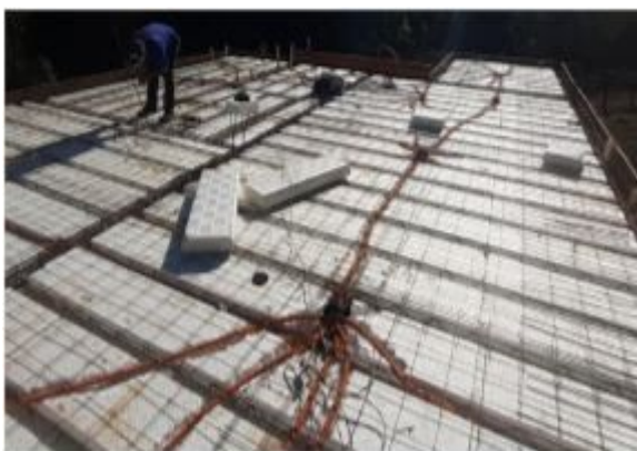
5. Tubulação elétrica concluída
