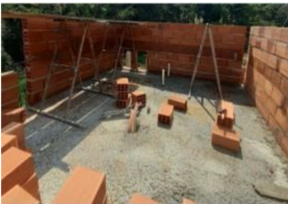
3. Pilares em andamento
