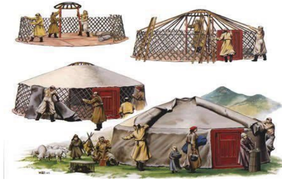
Figura 2 – Montagem tenda Yurt (Fonte: http://espaconaturalmente.eco.br/kit-tenda-yurt/ ).
