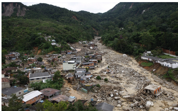
Figura 1 – Deslizamento em Teresópolis - RJ (Fonte: http://especiais.ig.com.br/zoom/enchentes-no-rio-de-janeiro/ ).
