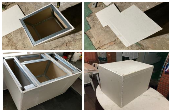
Figuras 2, 3, 4 e 5 – Montagem Cubo Drywall (Fonte: Autor 2020).
