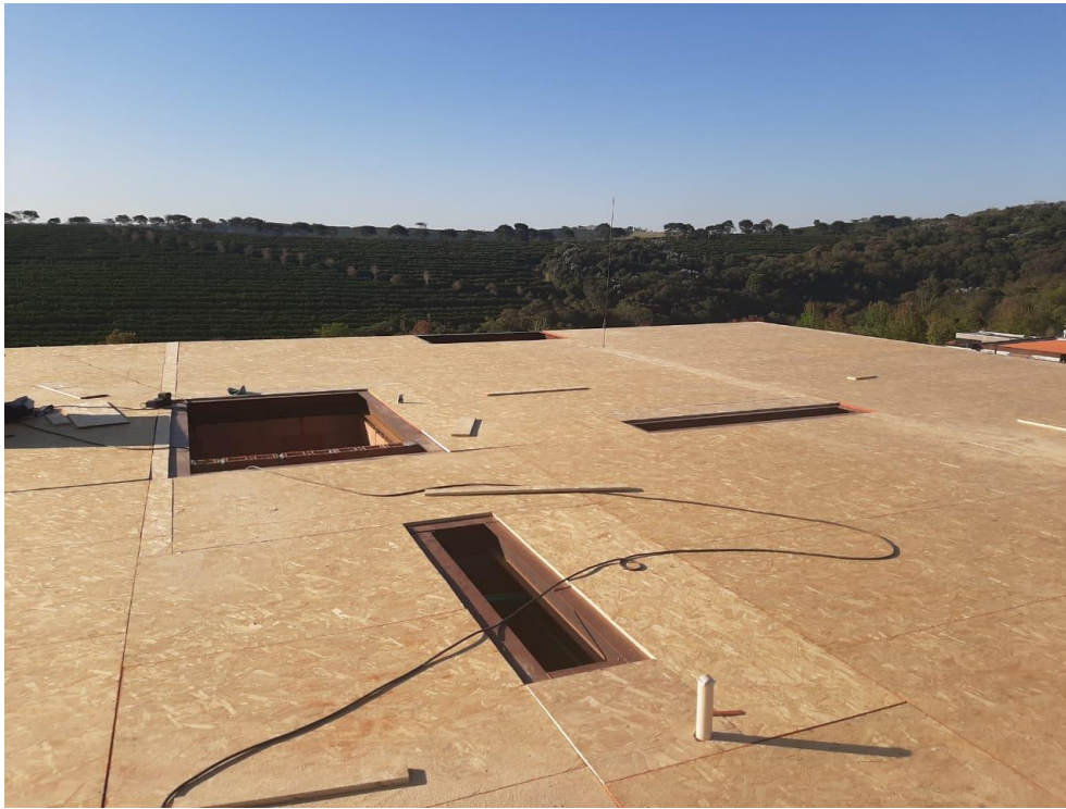
Fonte: Próprio autor Figura 19 – Instalação das placas OSB
