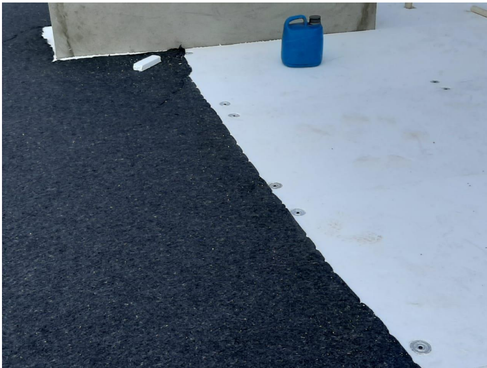
Fonte: Próprio autor Figura 19 – EPS de alta densidade coberto por manta bidim.
