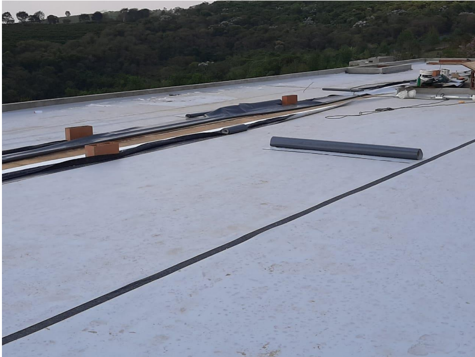
Figura 19 – EPS de alta densidade coberto por manta bidim.
